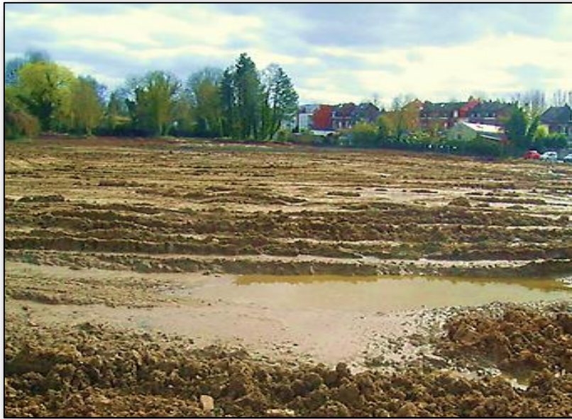
Malaxage du sol par passage répété sur une micro dépression qui se surcreusée
