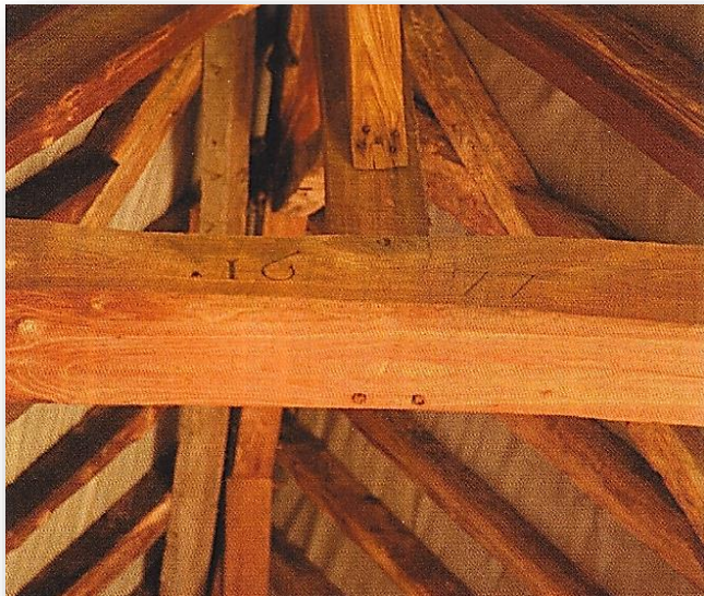
Inscription 1677 sur l'entrée retroussée de charpente et sous le poinçon vertical mortaisé et chevillé. Pour sa part, au premier plan, la contre fiche clouée n'est pas d'origine.
