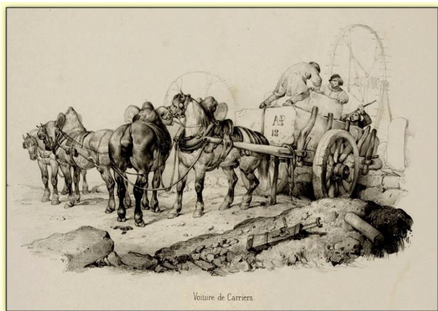
Dessin de Jean Victor ADAM avec au premier plan à droite un cric de carrier et un rondin en bois d'un chemin de roulage en bois
