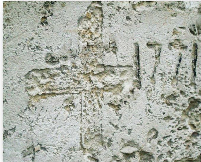
Inscription 1771 sur la craie de la façade Sud ; peut-être la trace d'une rénovation ou d'une extension. L'altération des microfossiles et nannofossiles, touchant également la gravure, atteste de l'ancienneté
