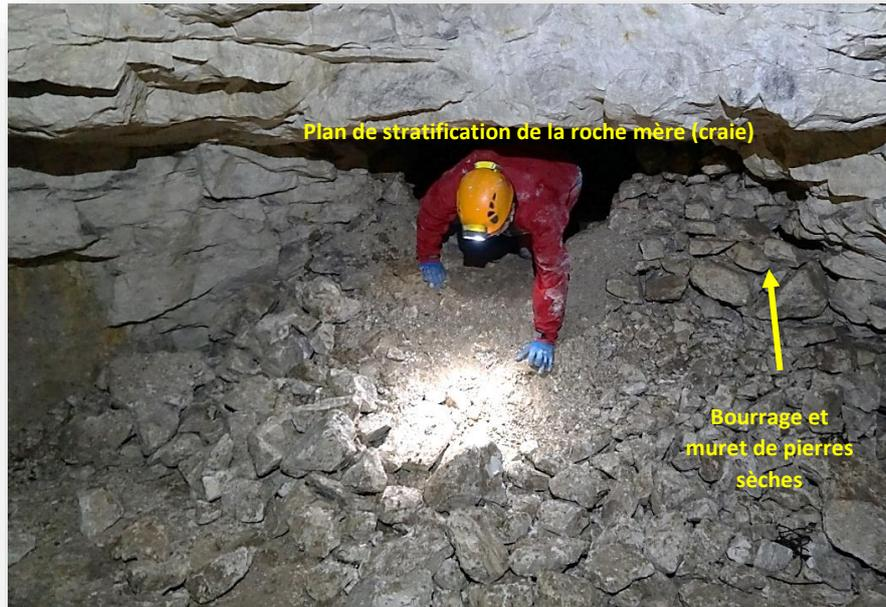
Passage ouvert au travers d'un bourrage. Les bourrages sont des remblais constitués de reste de tailles. Ces remblais sont soutenus par des murets de pierres sèches. La galerie est creusée sous un plan de stratification et former le ciel de voûte.
