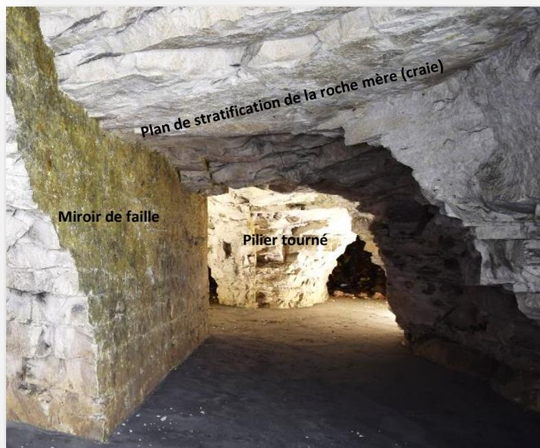
Au premier plan, creusement par havage à partir d'un miroir de faille, en suivant le plan de stratification. Au second plan, creusement par pilier tourné
