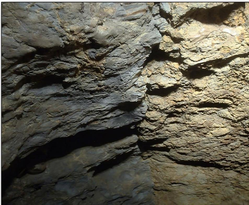
Voûte d'une galerie au contact du calcaire (à gauche) et du schiste (à droite)
